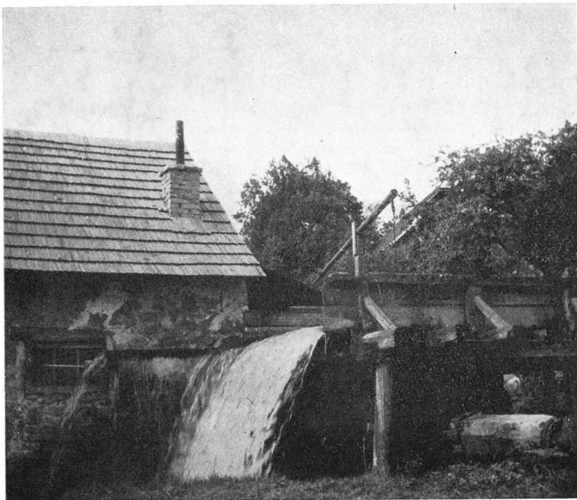
Obr. 3. Prúd vody je sklopením otvoru v náhone vedený ponad vodné koleso priamo do jarka. Heřpa 1959
