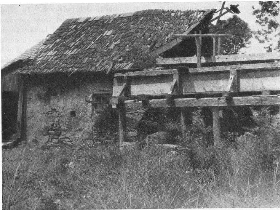
Obr. 1. Budova valchy s časťou náhonu. Hefpa 1954. Autorkou všetkých fotografií v článku je J. Pátková
